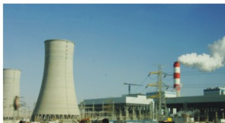
灵武电厂1000MW超超临界空冷机组
